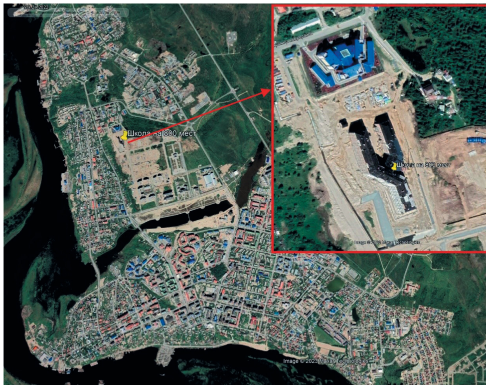
Рис. 1. Объект обследования – здание школы на 800 мест в микрорайоне Богдана Кнунянца
