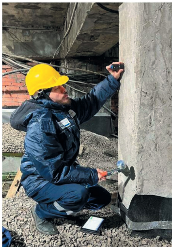
Рис. 3. Пример работ по определению длины свай с использованием Спектра 4.3
