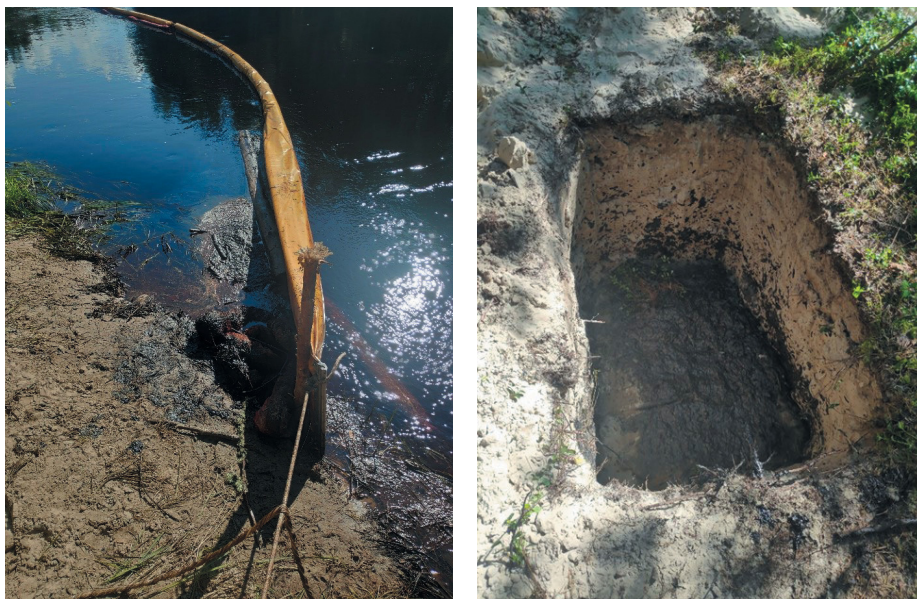
Рис. 3. Боновое заграждение на реке Котутаяха и шурф, заполненный нефтью, уловленной боровым заграждением
