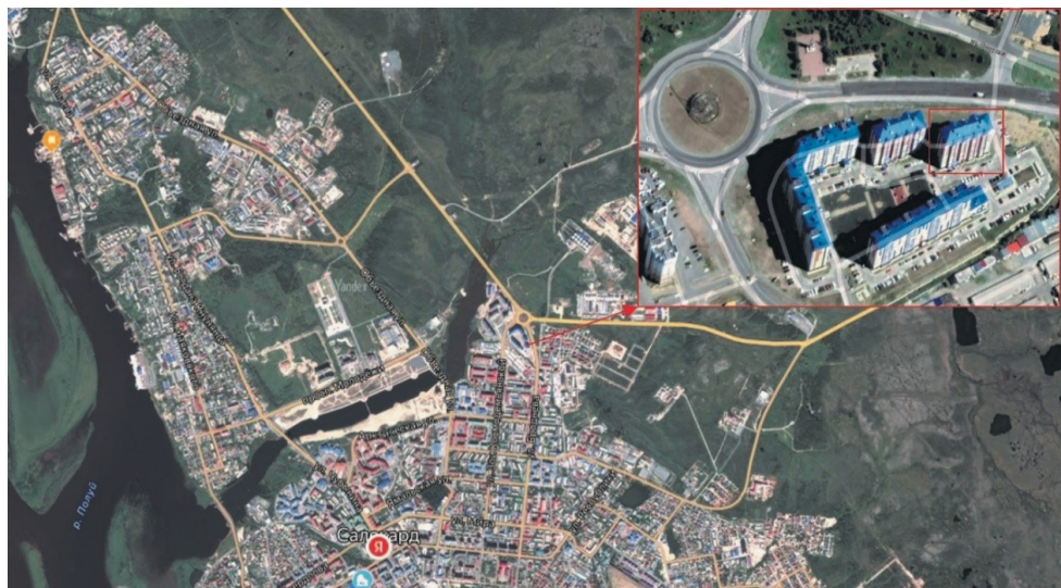
Рис. 5. Объект обследования — многоквартирный жилой дом, ул. Зои Космодемьянской, 68
