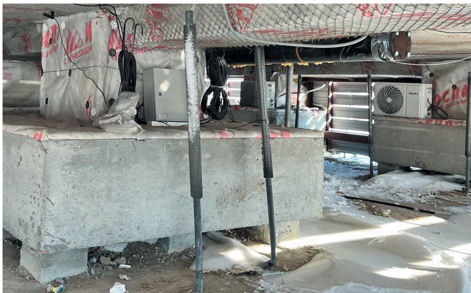
Рис. 6. Дефект СОУ. Наличие пенопласта в оребрении
