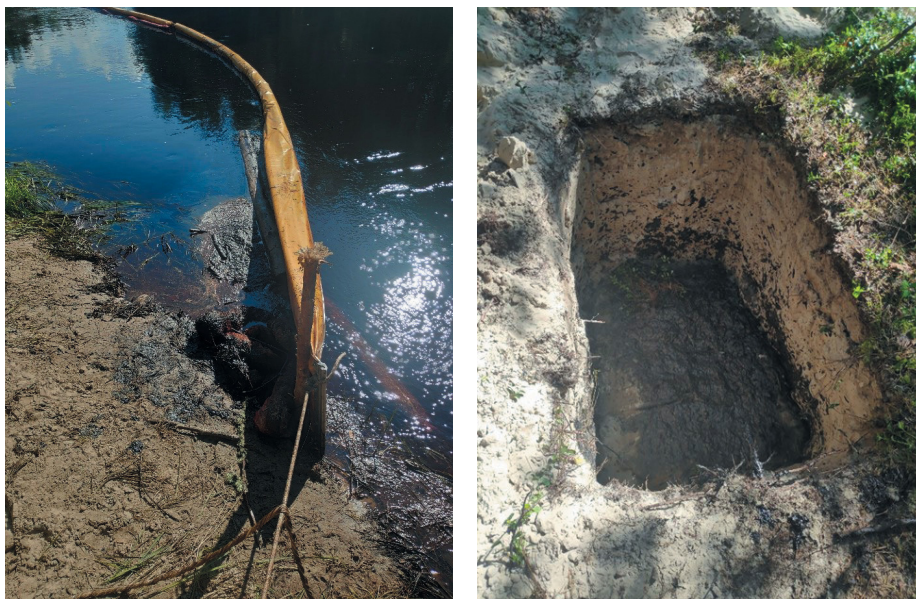
Рис. 3. Боновое заграждение на реке Котутаяха и шурф, заполненный нефтью, уловленной боровым заграждением
