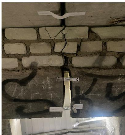
Рис. 1. Раскрытие деформационного шва в ростверке фундамента здания ТИРа (фото из архивов Научного центра изучения Арктики)
