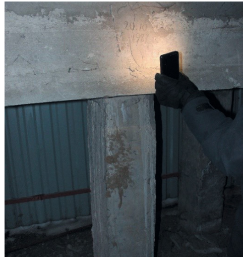
Рис. 13, 14. Фиксация трещин в ростверке фундамента в центральной и южной частях здания
