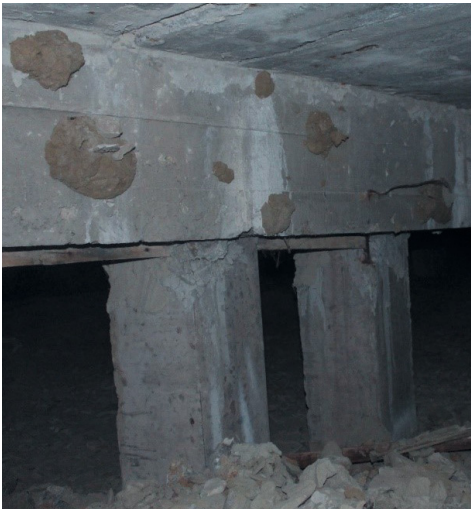
Рис. 13, 14. Фиксация трещин в ростверке фундамента в центральной и южной частях здания
