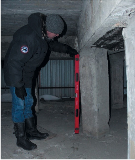
Рис. 11, 12. Отклонение от вертикали свай фундамента в южной части здания
