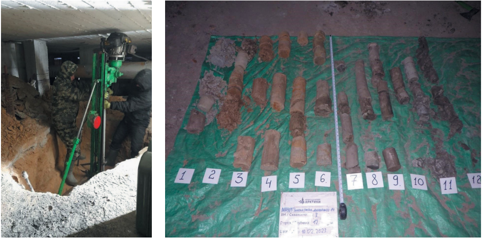
Рис. 2, 3. Буровые работы и выгрузка образцов грунта в проветриваемом подполье объекта исследований, скв. 3
