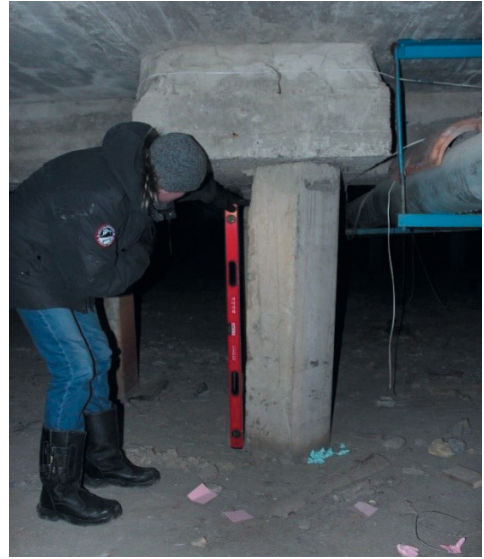
Рис. 11, 12. Отклонение от вертикали свай фундамента в южной части здания
