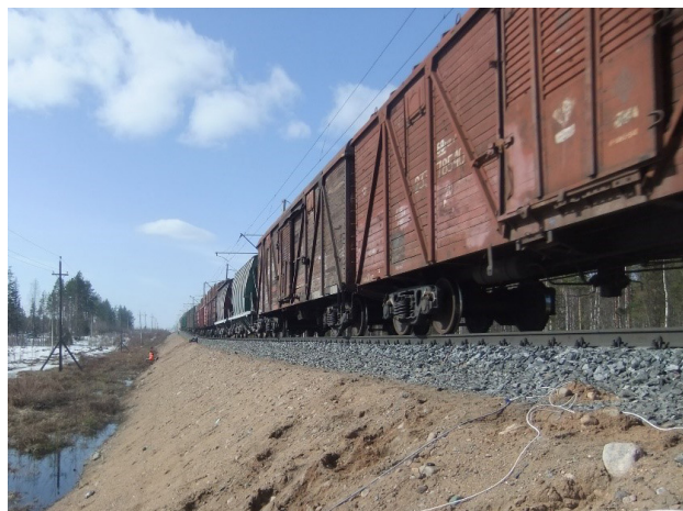
Рис. 1. Насыпь на торфяном болоте (Архангельская область)
