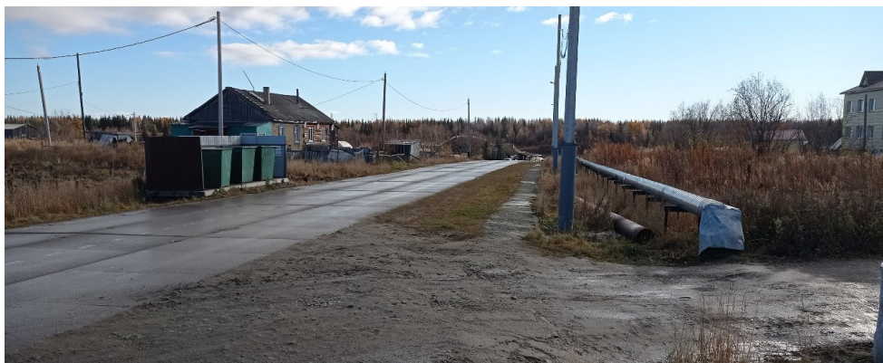
Рис. 2. Автомобильная дорога общего пользования с твердым покрытием из железобетонных плит по улице Зверева, с. Катравож
