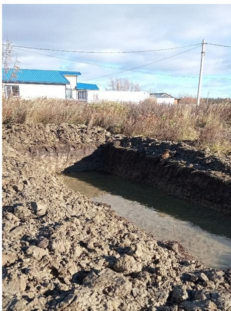
В процессе буровых работ грунтовые воды были вскрыты всеми скважинами на глубине 0,0-0,6 метра. В скважине № 2 грунтовые воды вышли на дневную поверхность. Наличие поверхностных и надмерзлотных грунтовых вод, имеющих температуры выше нуля градусов Цельсия, приводит к ускорению процесса растепления грунтов. На рисунке 5 приведен уровень грунтовых вод на соседнем участке по улице Зверева, расположенном в тех же геокриологических и ландшафтных условиях.
