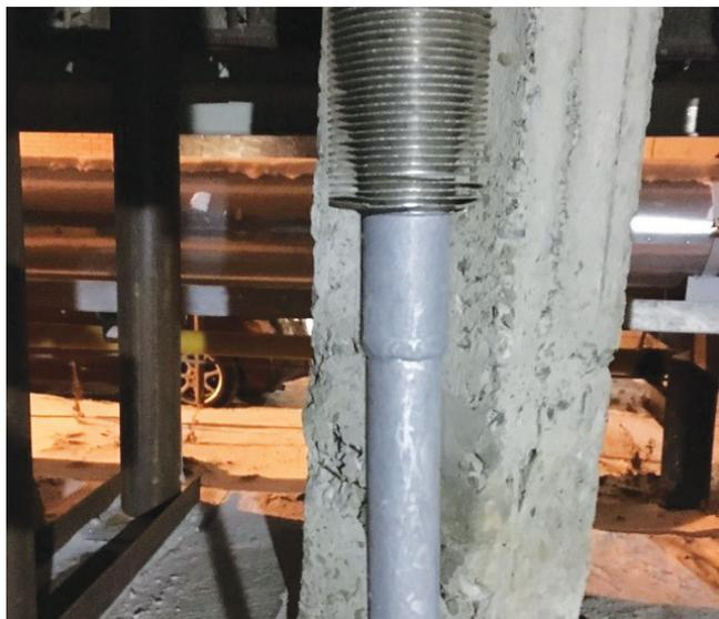
Рис. 5. Термостабилизатор около свай
