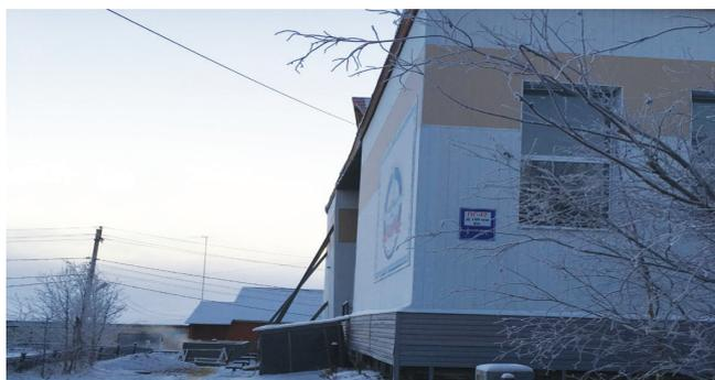
Рис. 1. Неравномерная осадка здания Ямальского агроэкономического колледжа
