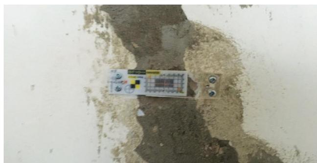
Рис. 3. Деформационные маркеры на стене здания
