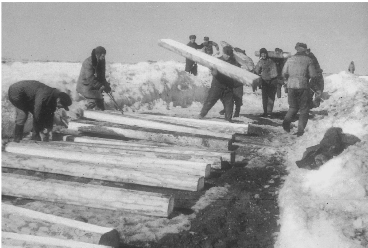
Рис. 10. Укладка шпал на ледовой переправе между Лабитнангами и Салехардом. 1950 год. Негатив, ЯНМ 16368/9, ФН-2900
