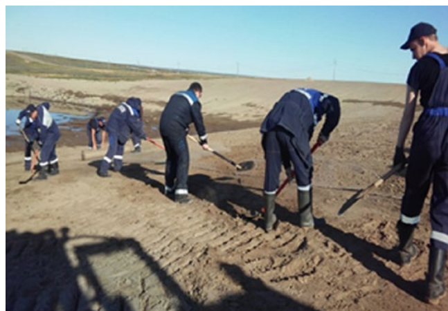
Рис. 12. Укладка покрытия «БиоСТЭК» силами ООО «Газпром добыча Надым», август 2016 г.
