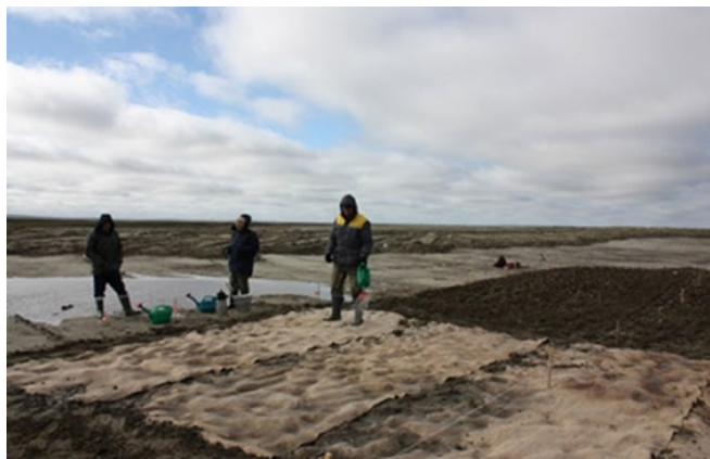
Рис. 2. Закладка экспериментальных участков рекультивации на карьере минерального грунта № 4 Бованенковского НГКМ с использованием биоматов марки БТ-СО/130 (2,0) в 2010 г.
