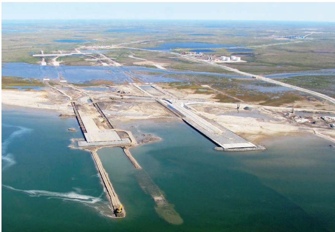
Рис. 5. Ямальский береговой участок подводного перехода МГ через Байдарацкую губу. Вид на север, июль 2013 г.
