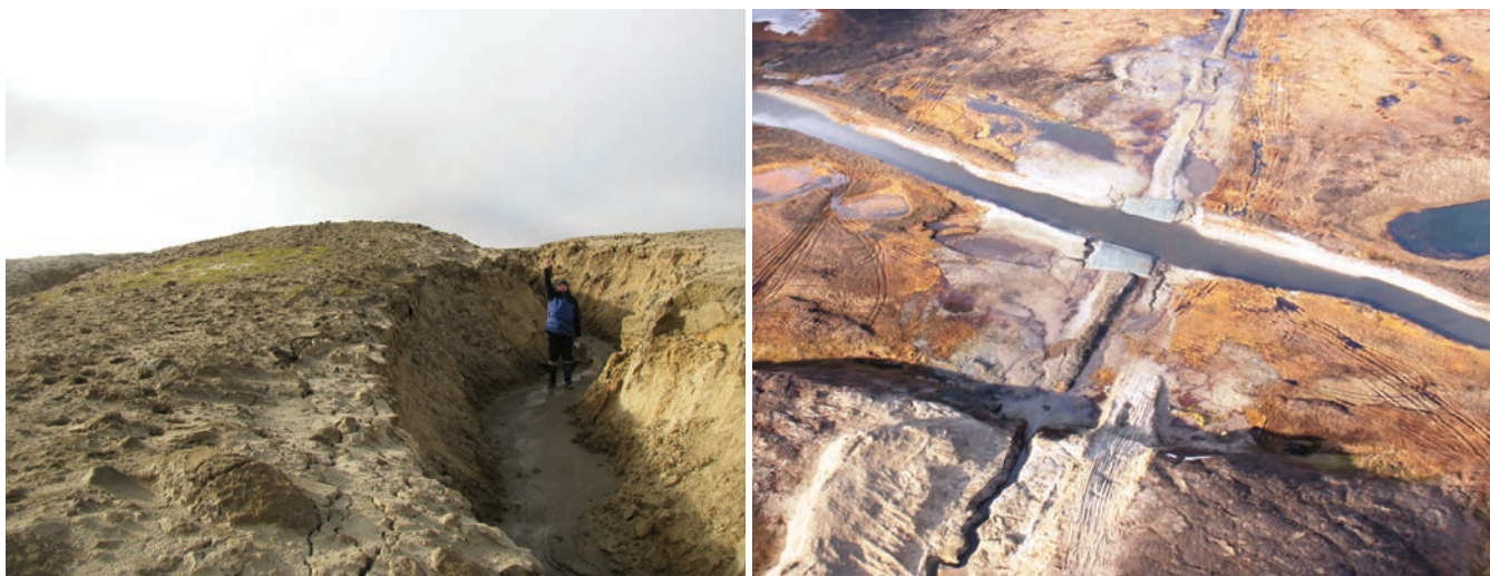
Рис. 3а, 3б. Оврагообразование вдоль трассы газопровода. Ямал, 2013 г.
