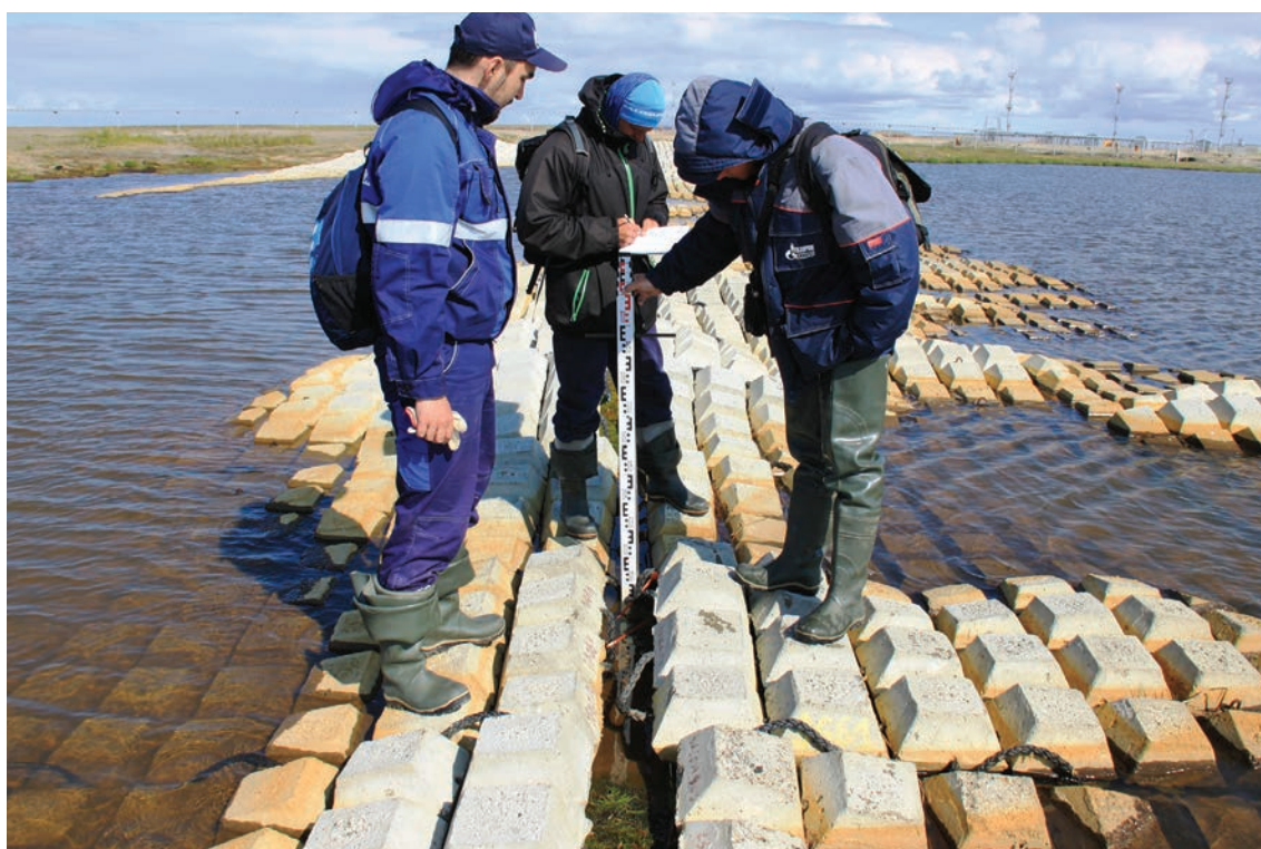
Рис. 9. Участок МГ на Ямальском берегу с уложенными бетонными матами. 2-я нитка, июль 2015 г.
